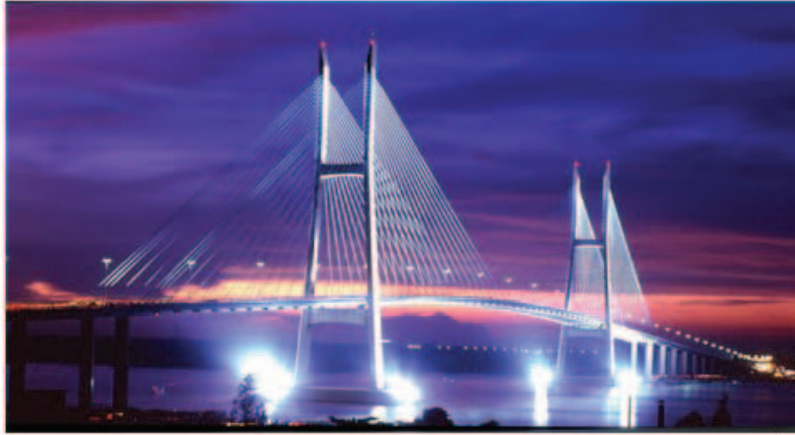
Nhiều công nghệ mới lần đầu tiên được áp dụng tại Việt Nam trong xây dựng cầu Rach Miếu
